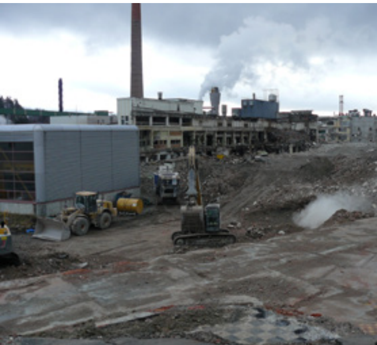
Rivingsarbeidet pågår for fullt på Follum for å få på plass Treklyngen. Foto: Steffen Mørtvedt
