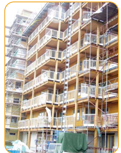
Massivtre i fleretasjers hus, Växjö, Sverige.
